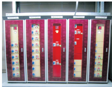
Bảng điều khiển MCC hỏa hoạn
