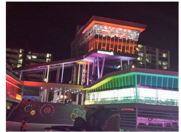
전기 인테리어 공사
