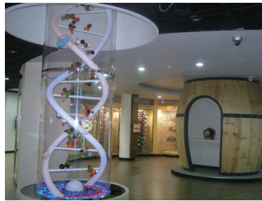
전기 인테리어 공사
